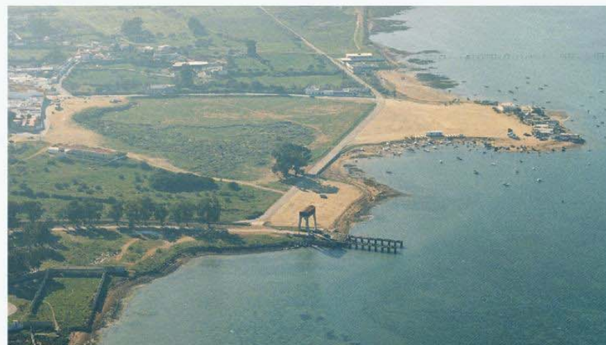
Fotografía oblicua del tramo en la que se aprecia la ocupación del DPMT en la Casería (sector derecho) y las zonas verdes a la izquierda que actualmente están en muchos casos en proceso de urbanización.
