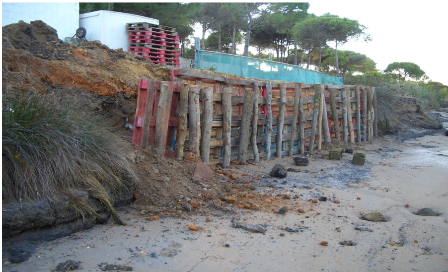
Ilustración 12. La inestabilidad de las márgenes, la amenaza de la erosión al restaurante allí construido y la inacción de la administración pública hace que el privado, el particular, en este caso el propietario de dicho restaurante, construya de forma precaria, con materiales de desecho (palets de obra relleno de escombros), su propia obra de defensa. La cuestión es qué ocurrirá con los escombros de dicha obra de defensa, en el caso de que no esté bien realizado el trabajo de “ingeniería costera”, cuando aparezcan las lluvias torrenciales.
