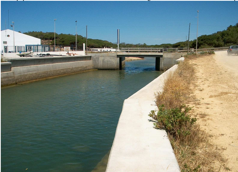
Ilustración 7. El encauzamiento de la desembocadura del río y la construcción de un puente sobre el tapón arenoso implicó el cambio más radical del ecosistema lagunar ya que ello supuso pasar de un régimen lagunar a otro intermareal.
