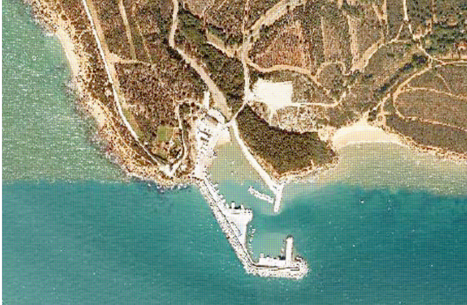
Ilustración 2. Imagen de la desembocadura río Roche en bajamar (2009). Puede observarse el crecimiento del puerto a partir de rellenos de la dársena exterior.
