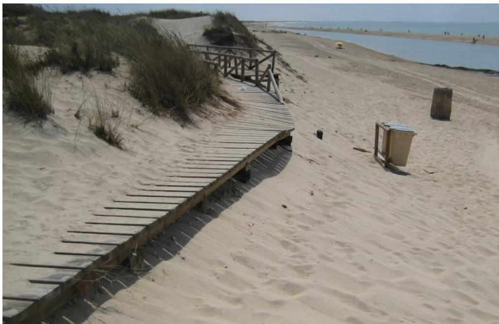
Imagen 13.2. Duna costera desmantelada parcialmente, como demuestra la pasarela volada y el pozo que queda aislado en lo que hoy es la parte alta de la playa. Litoral de Doñana, 2010 que denuncia la pérdida de la capacidad de los ecosistemas litorales de generar múltiples servicios, muchos de ellos prioritarios (Fuente: F. Borja)
