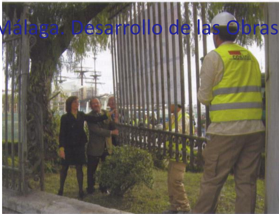
Retirada de la verja en el puerto de Málaga
