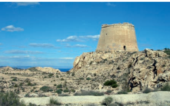
Torre Mesa Roldán (torre artillada), Carboneras (Almería)
