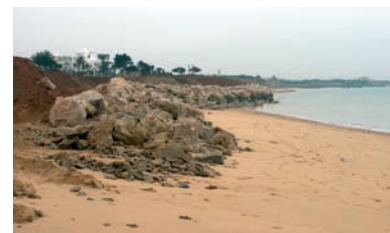
Obras de ingeniería costera, Chipiona (Cádiz)
