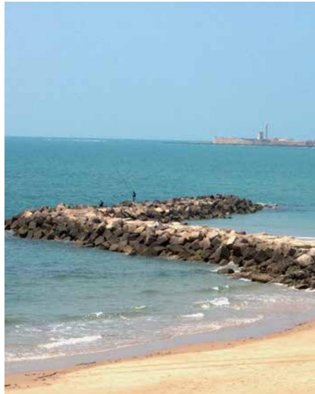
La presencia de espigones altera la dinámica natural del borde costero, los flujos de agua y el aporte de sedimentos.
